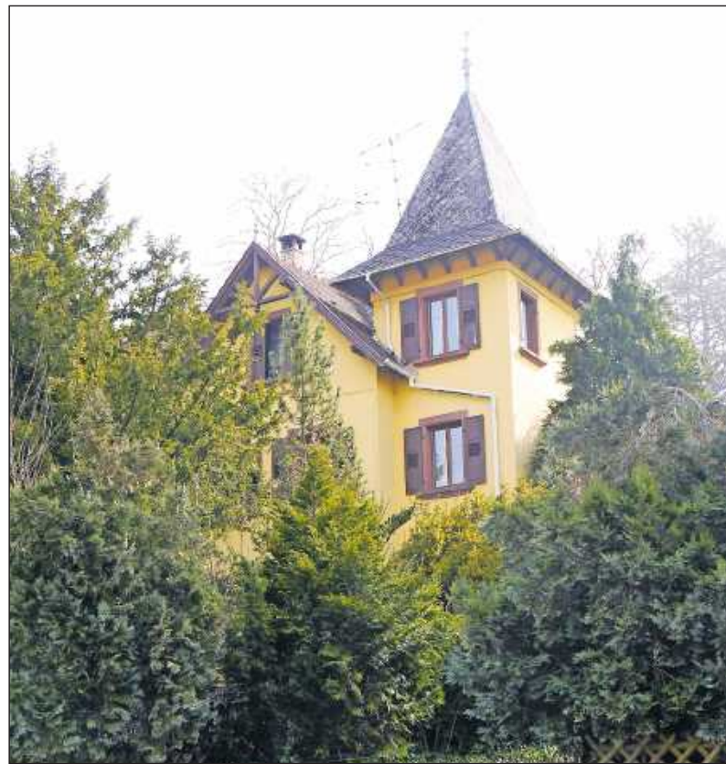
In diesem stattlichen Haus in Lembach wohnte der Landarzt und Schriftsteller mit Ehefrau Denise, und hier hatte er auch seine Praxis. FOTO: VST
