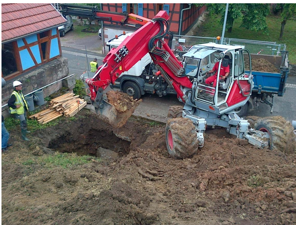
Chantier sur le réseau à Langensoultzbach
