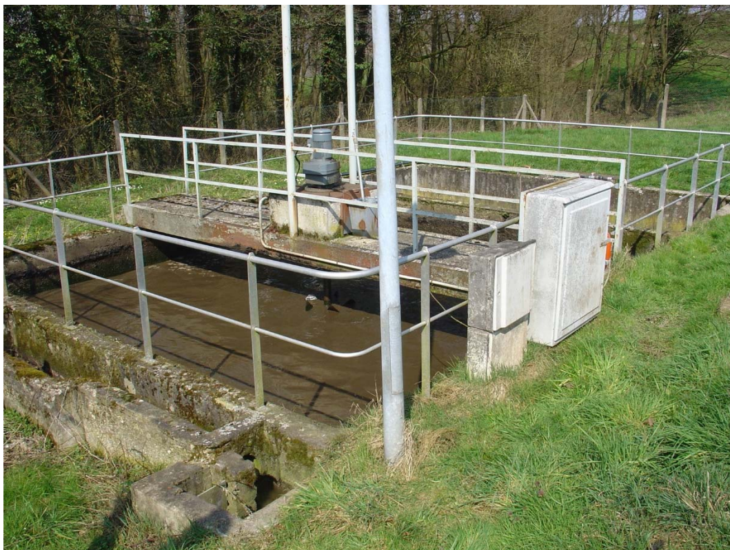
Station d'épuration de Pfaffenbronn : avant travaux
