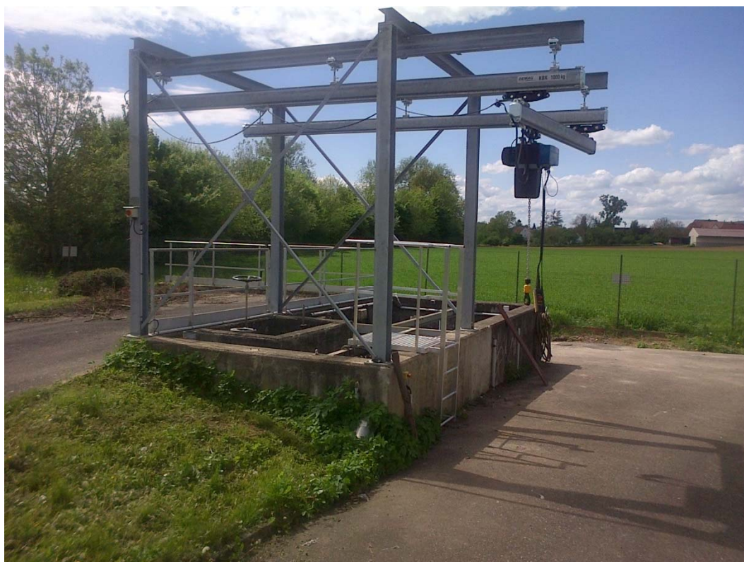
Station d'épuration de Pechelbronn : portique de levage sur poste d'entrée
