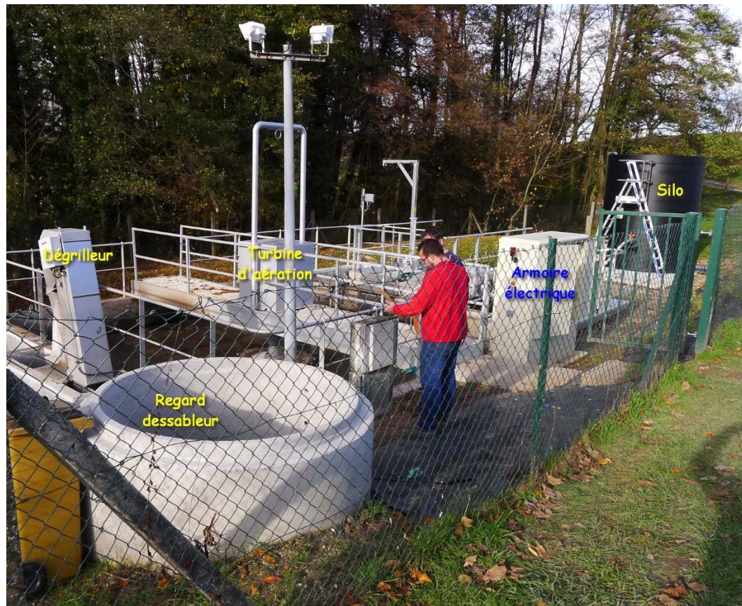
Station d'épuration de Pfaffenbronn : après travaux
