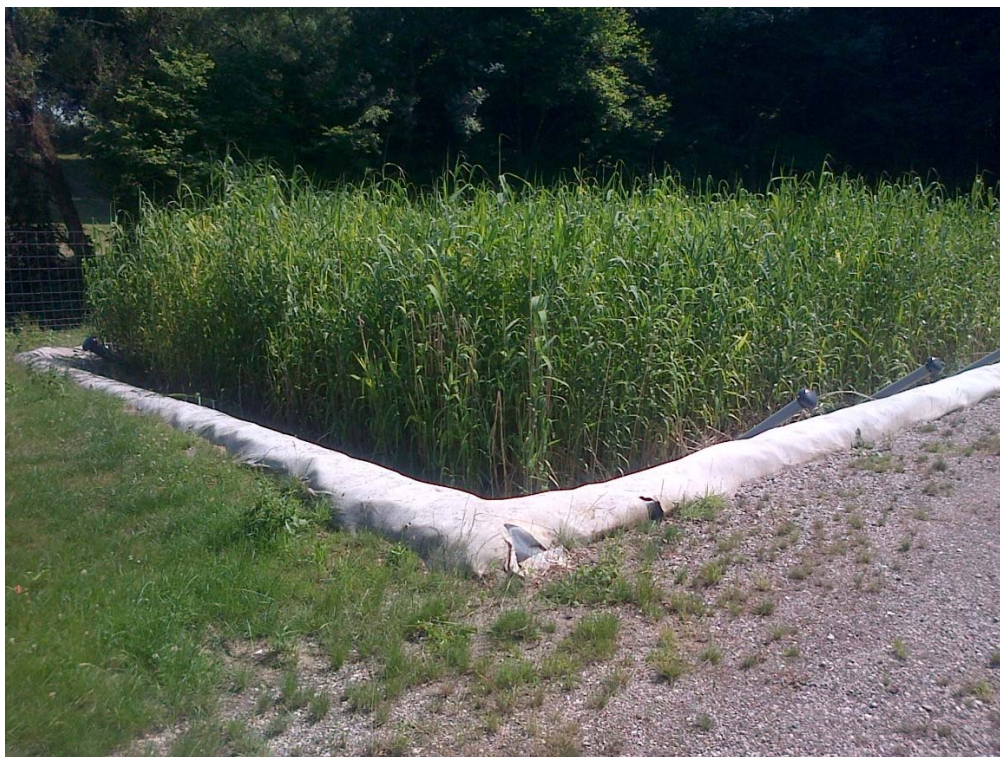
Station d'épuration de Mattstall : second étage
